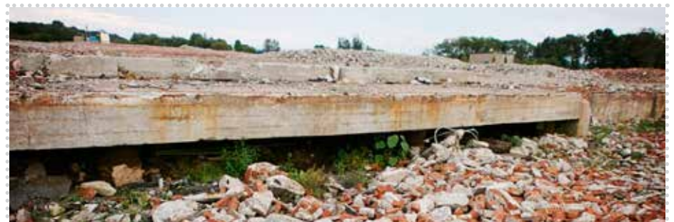
Site #2 - Amas de béton bitumineux
