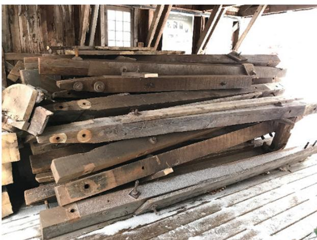
**Rayons de la roue** : 3 mètres, 25 pièces quelques-unes boulonnées à des traverses
