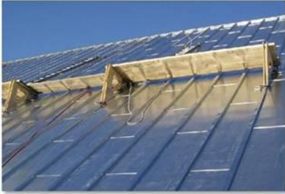
Figure 13 – Toiture en tôle à baguette
