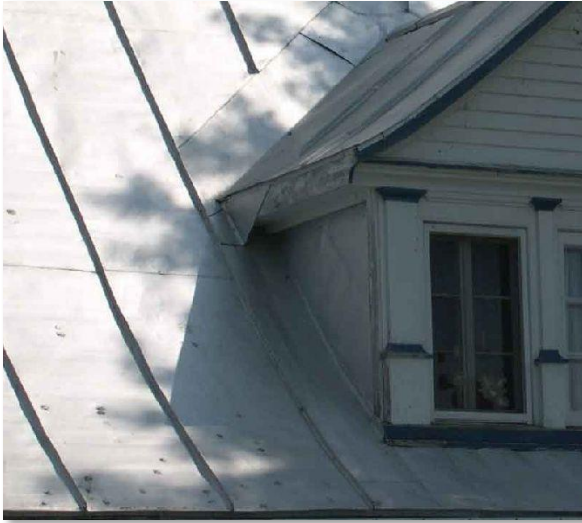
Figure 15 – Toiture en tôle pincée ou agrafée
