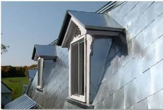
Figure 14 – Toiture à la canadienne
