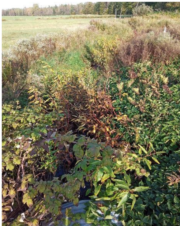
Photo 16 : Sortie des égouts pluviaux
