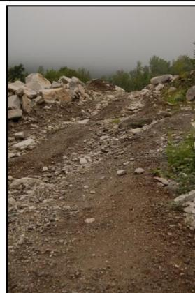
**Point 2 :** Érosion (ravinement) de la surface de roulement d'un chemin de machinerie.
