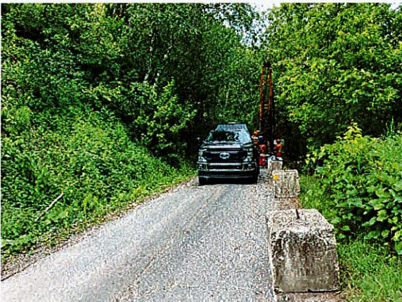
Vue du forage 21F3
