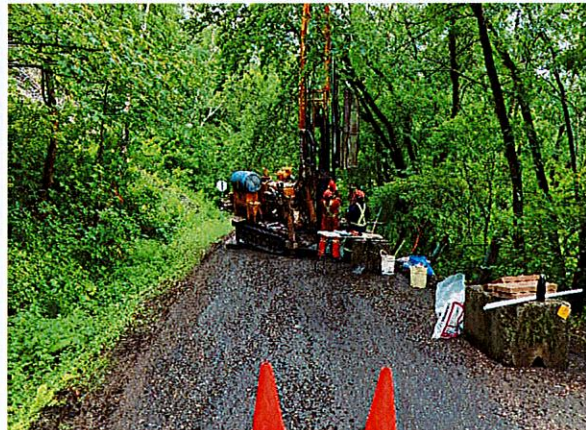
Vue du forage 20F5
