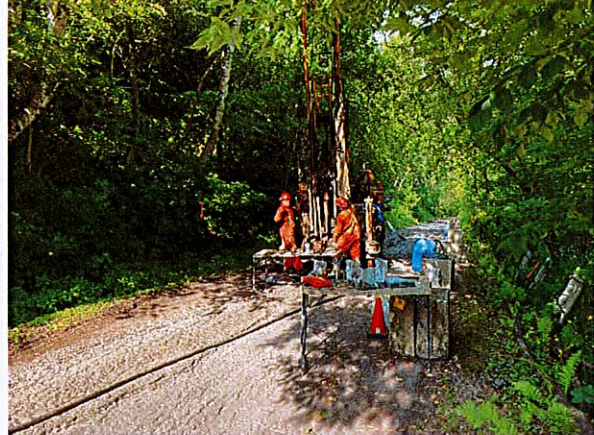
Vue du forage 21F2
