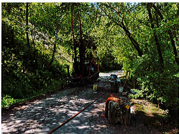
Vue du forage 21F6
