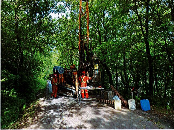
Vue du forage 21F1
