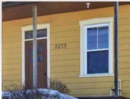
PORTE AVEC IMPOSTE ET FENÊTRES À GUILLOTINE DOTÉES DE CHAMBRANLES
