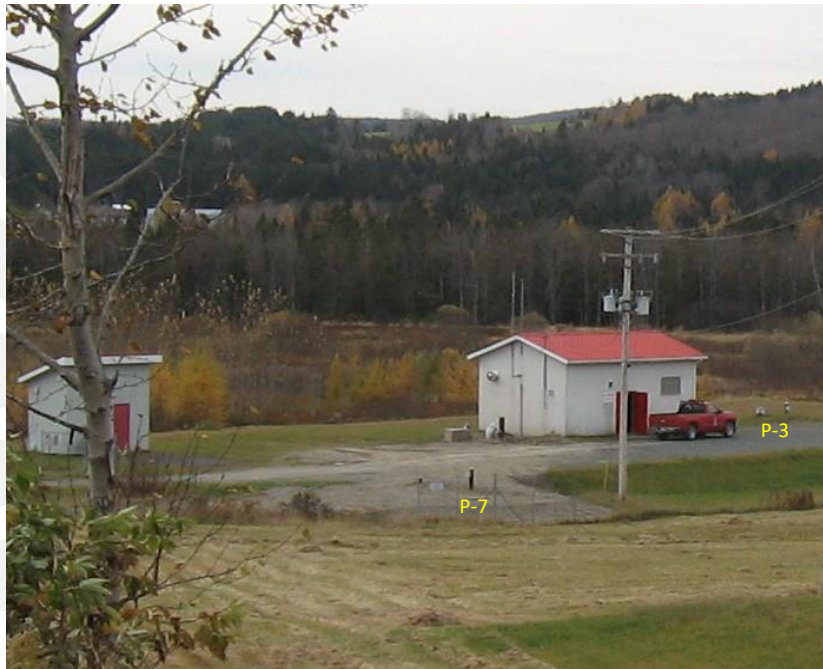
Vue du bâtiment technique pour le traitement, 20 octobre 2019
