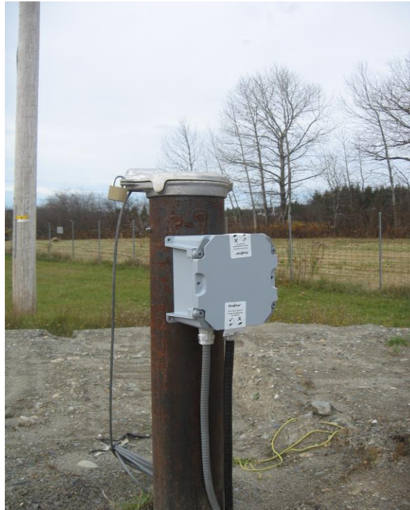
Vue de la tête du puits P-7, 22 octobre 2019.
