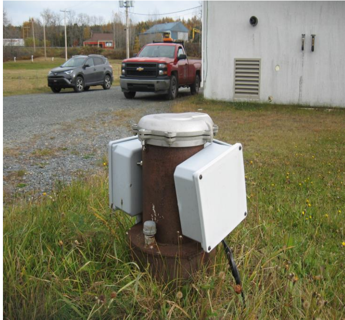
Vue de la tête du puits P-3, 22 octobre 2019.
