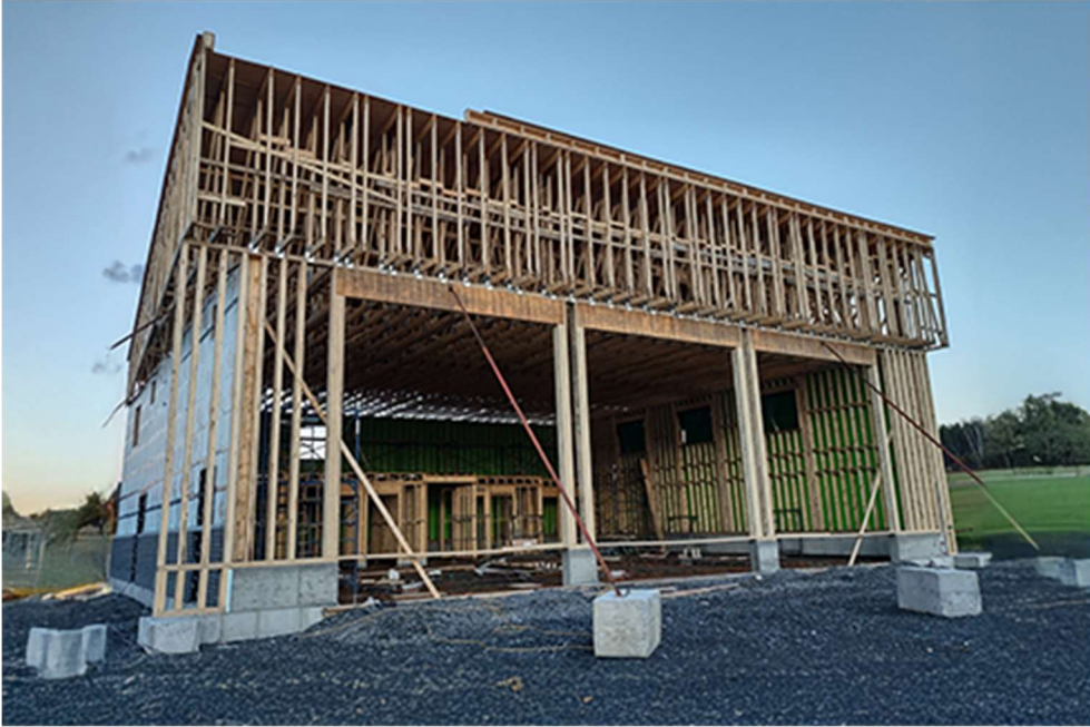
Structure principale en bois
