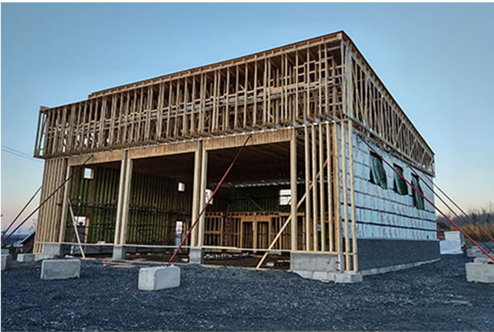
Structure principale en bois
