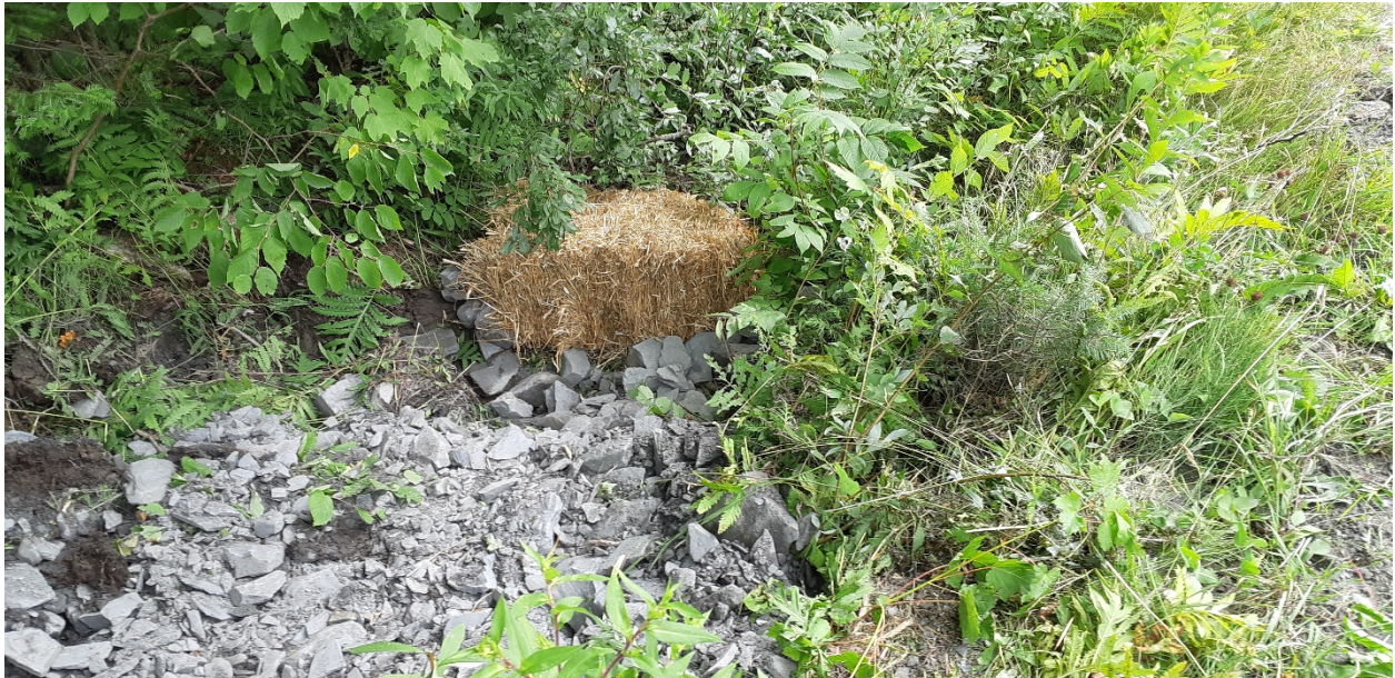
Figure 7: Un ballot de paille a été placé à la sortie du bassin de sédimentation, afin de capter les sédiments encore dans l'eau
