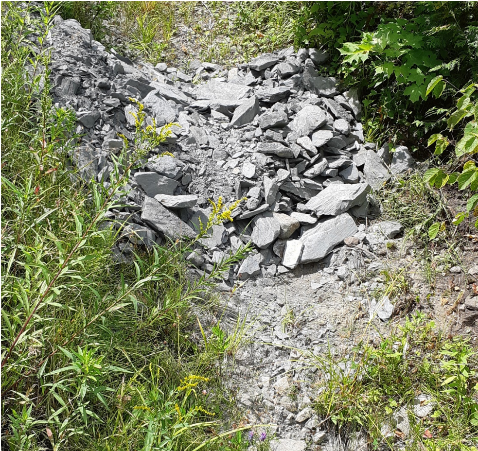
Figure 8: Seuil après l'aménagement
