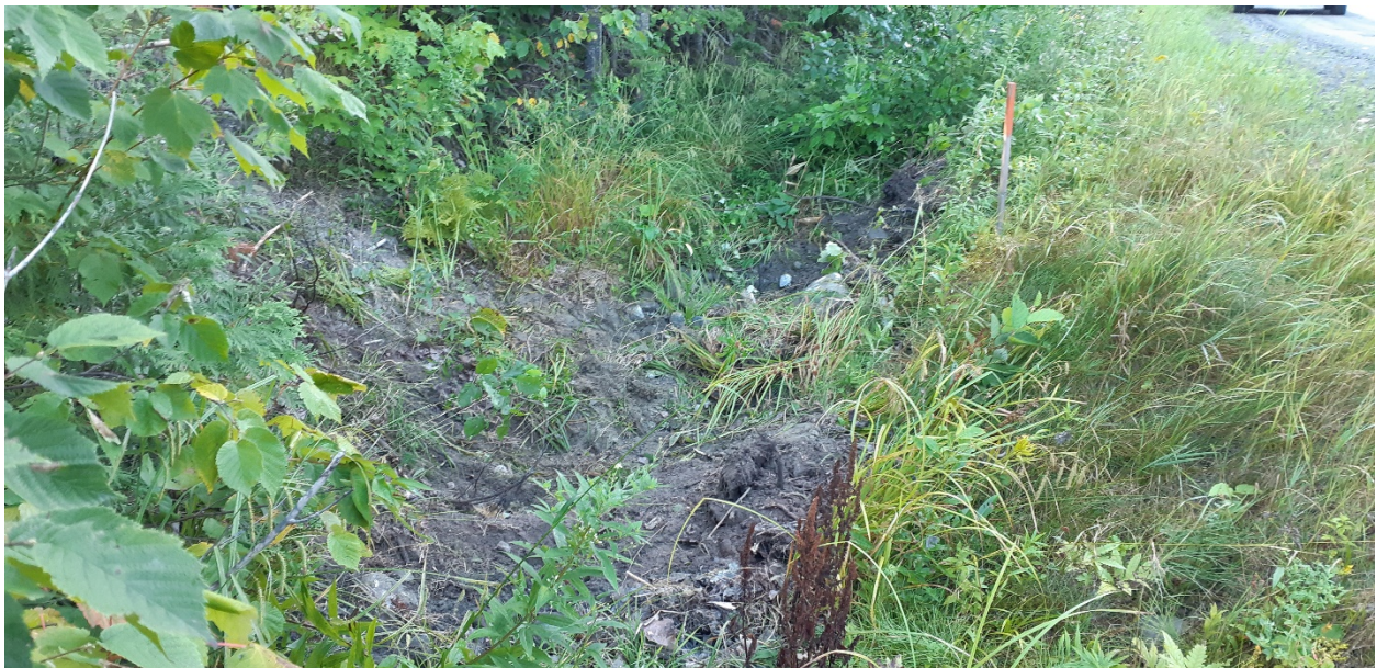
Figure 5: État du fossé avant les travaux
