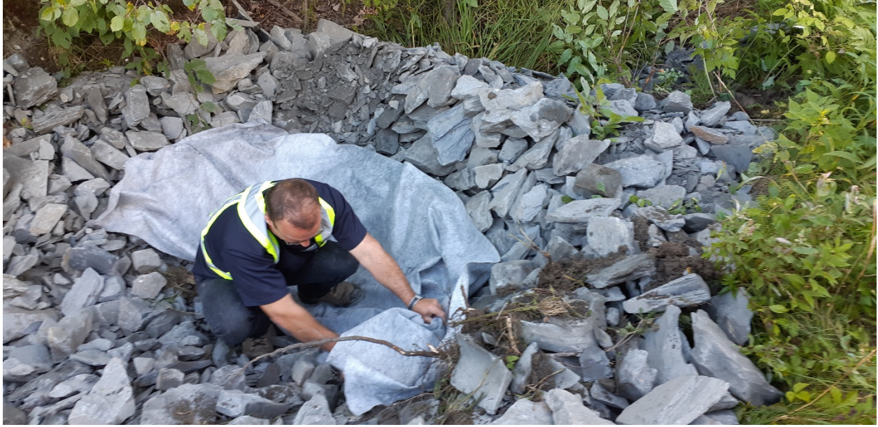
Figure 6: Employé de la municipalité de Sainte-Cécile-de-Whitton en train d'installer une membrane géotextile au fond du bassin de sédimentation
