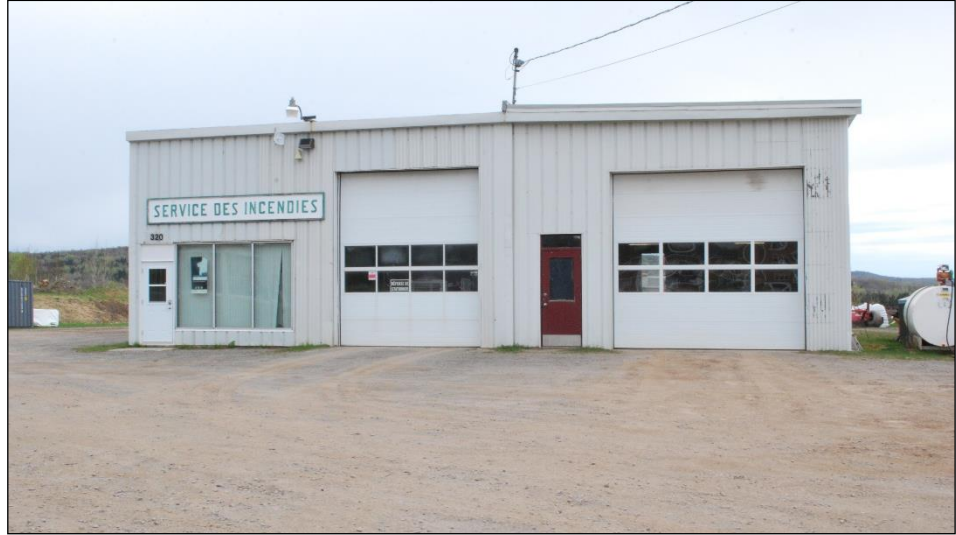
Photo 25. Service incendie et garage municipal
