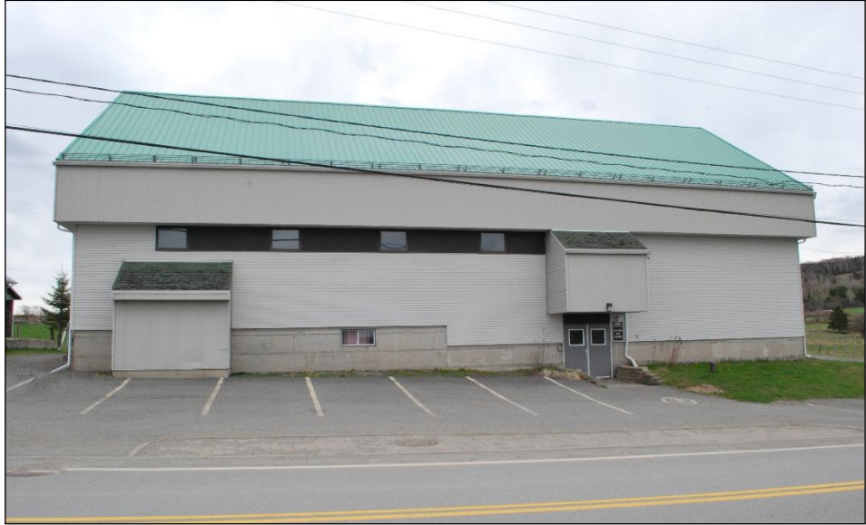
Photo 26. Centre des loisirs
