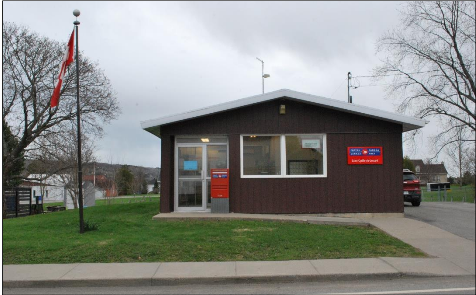
Photo 4. Bureau de poste (route 285)
