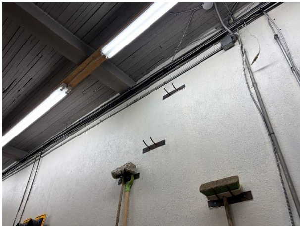
Photo 3 Baie 1 – Appui des poutres sur le mur entre la baie 1 et la baie 2
