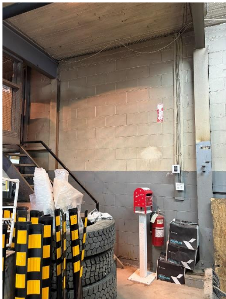
Photo 5 Baies 2-3 – Poutres prenant appui sur des colonnes en acier de dimensions variables
