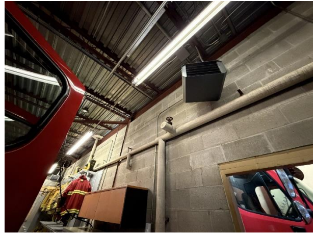
Photo 14 Baie 5 – Mur de blocs entre la baie 4 et la baie 5
