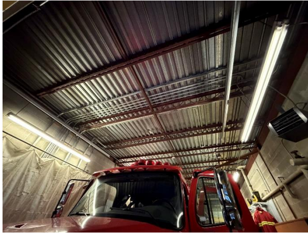
Photo 13 Baie 5 – Vue générale
