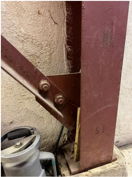
Photo 11 Baie 4 – Connexion contreventement en X - colonne
