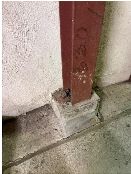
Photo 12 Baie 4 – Assemblage à la base d'une colonne
