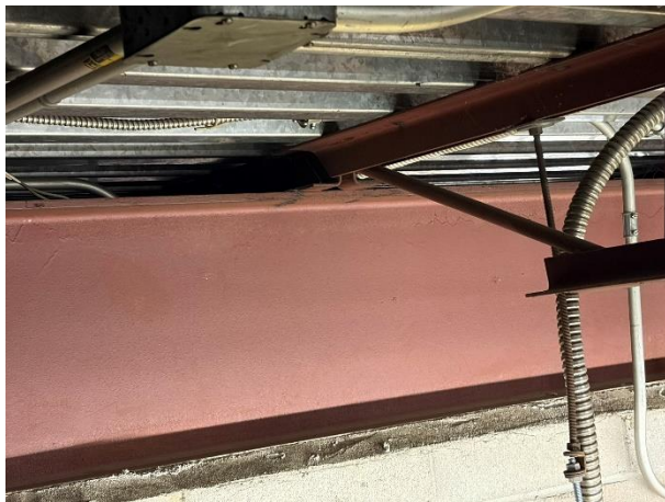
Photo 15 Baie 5 – Appui des poutrelles sur les poutres en rive
