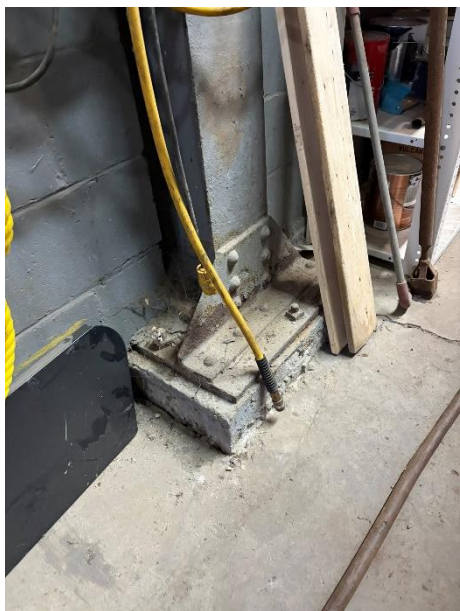
Photo 7 Baies 2-3 – Assemblage à la base d'une colonne
