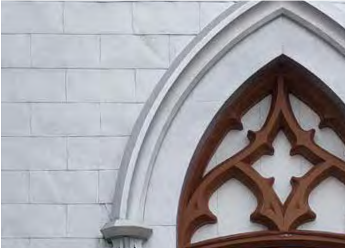
Figure 25 : Portail d'entrée secondaire de style gothique, avec un arc en ogive.
