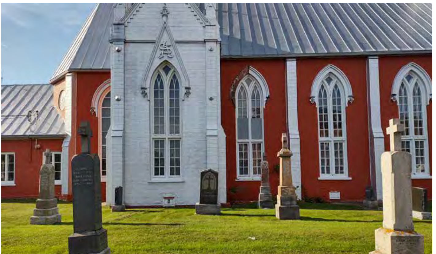
Figure 16 : Élévation latérale sud-est, vue depuis le cimetière, sacristie, chœur, transept et nef.
