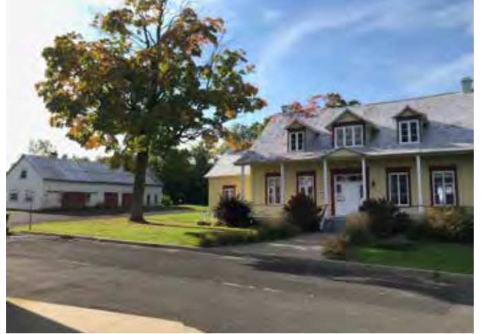
Figure 32 : Le presbytère depuis le portail d'entrée principal de l'église.
