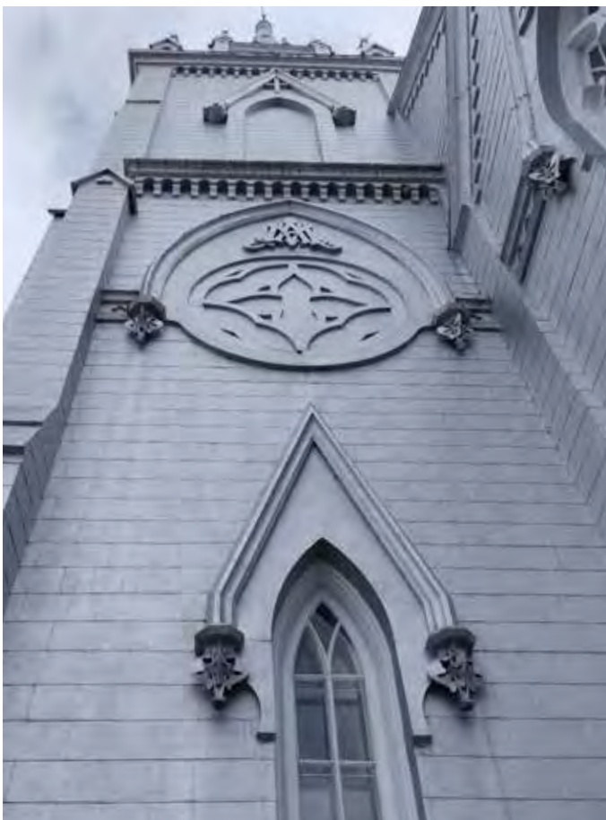
Figure 19 : Élévation latérale nord-ouest de la tour du clocher
