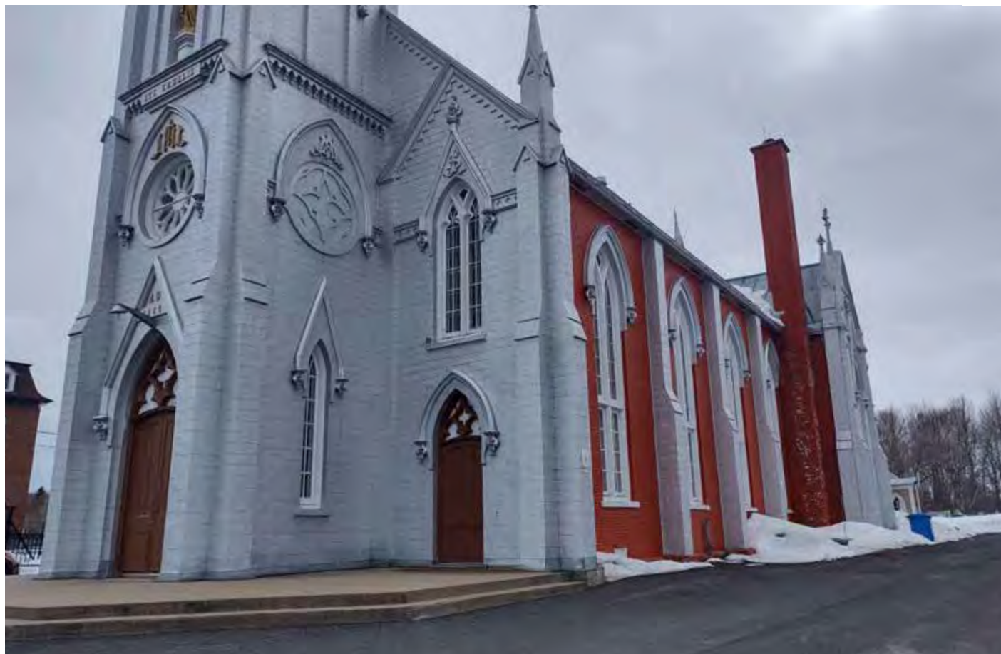
Figure 17 : Vue trois-quarts nord depuis le stationnement.
