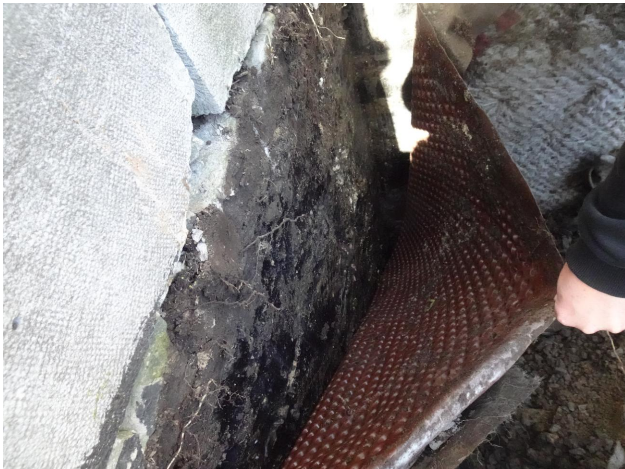
Photo 10 : membrane drainante installée sur le sous-bassement d'une bâtisse historique.
