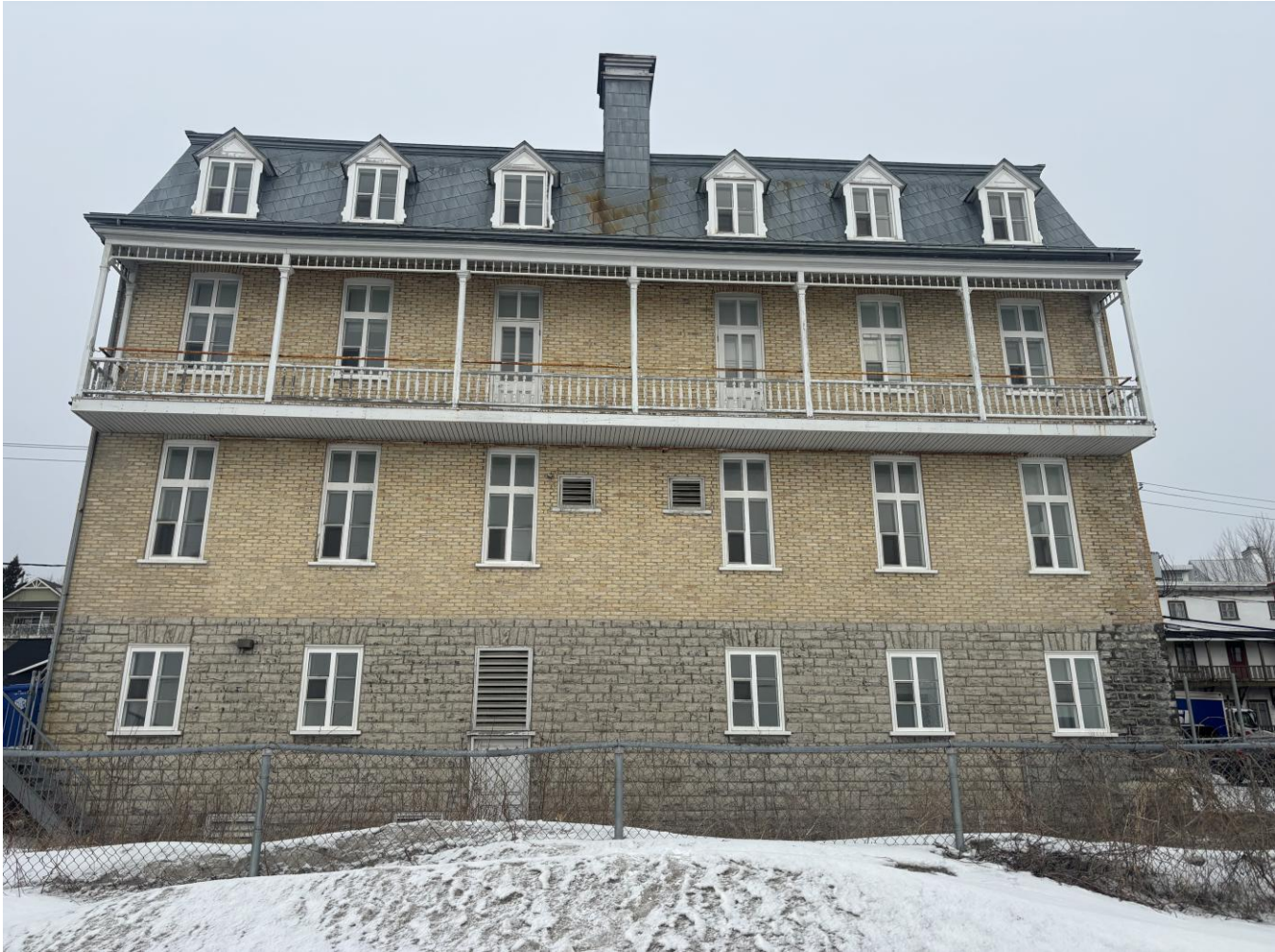
Photo 5 : Façade sud : les joints du sous-bassement et de la brique sont en bon état.
