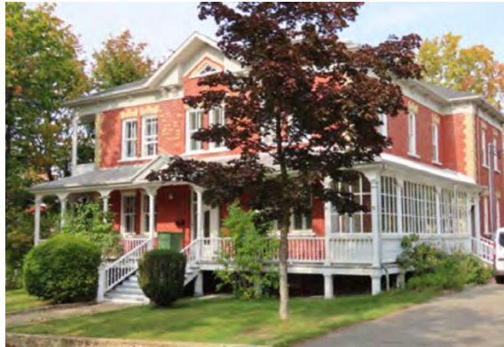
Ancien presbytère de Saint-Alexandre-de-Kamouraska offrant une valeur patrimoniale supérieure. Édifice remarquable non seulement par sa composition architecturale, mais aussi par son vaste solarium et ses fenêtres à petits carreaux. 455, avenue du Foyer.
