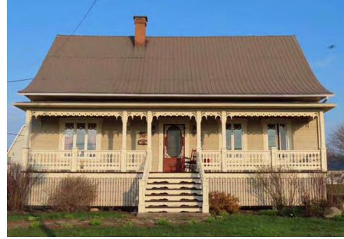
Le 683, route 230, remarquable par les éléments décoratifs en bois de la galerie : barreaux finement découpés du garde-corps, aisseliers au sommet des colonnes et lambrequins entre ces derniers
