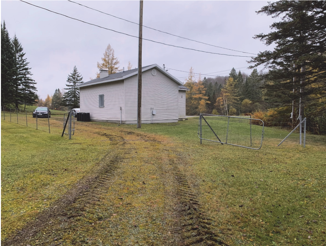
Photo 3 : Aperçu du bâtiment de production d'eau potable – 2020-09-17
