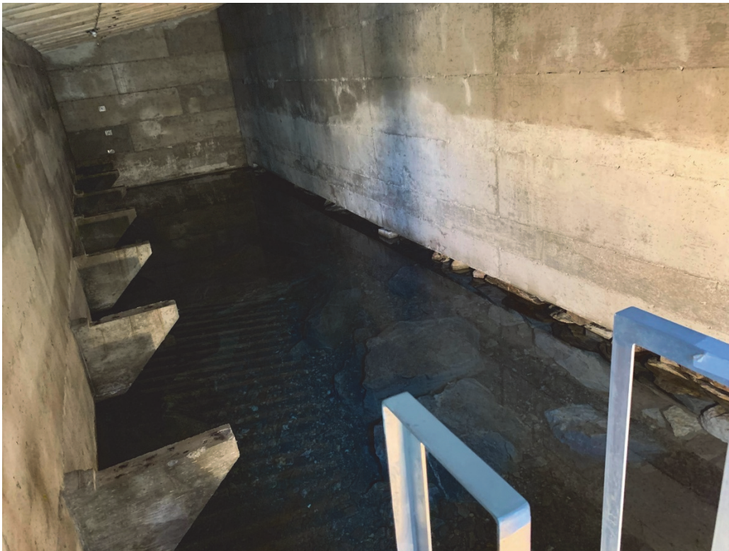
Photo1 : Aperçu du bassin de captage - 2020-11-26
