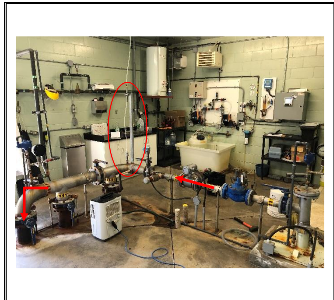
Photo 4 Date : 9 juin 2021 Description : Cheminement de l'eau dans l'usine : conduite d'eau brute du puits (à droite), point d'injection de chlore et circulation d'eau traitée avant la sortie du bâtiment.
