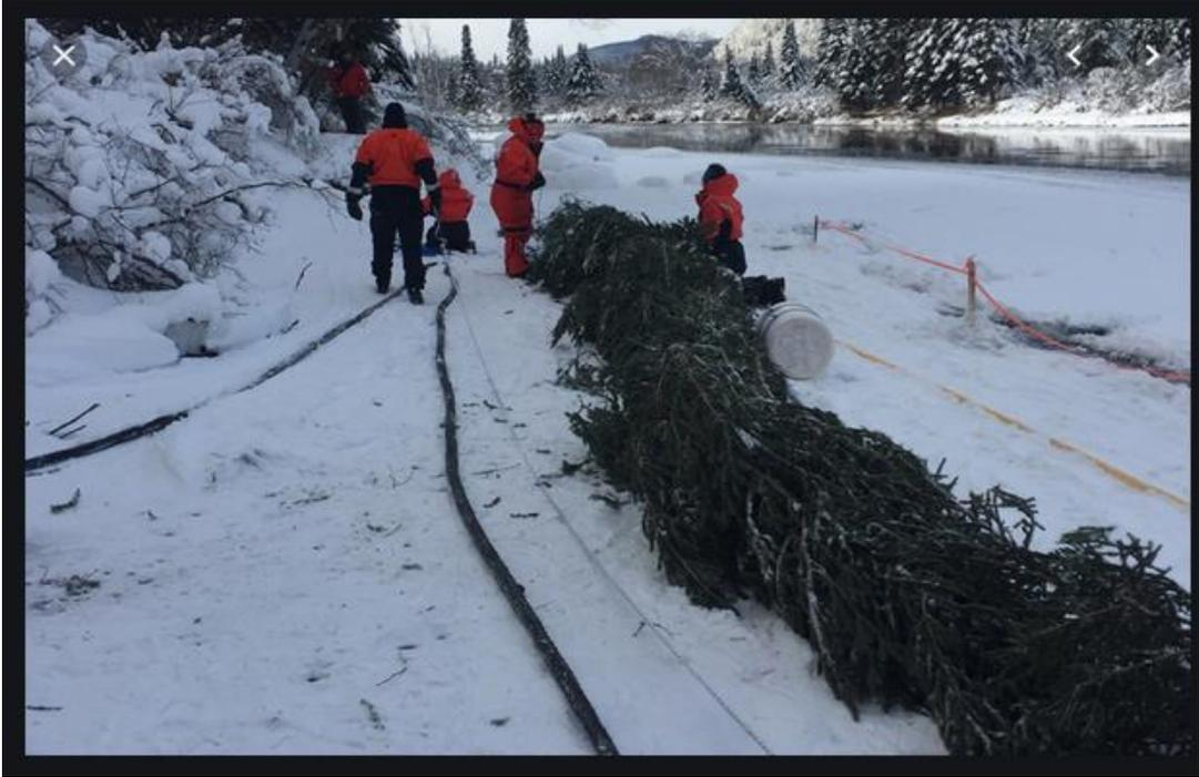
Figure 5. Préparation des épinettes et sapins pour la pose sur le câble en polyéthylène (aucune machine nécessaire)
