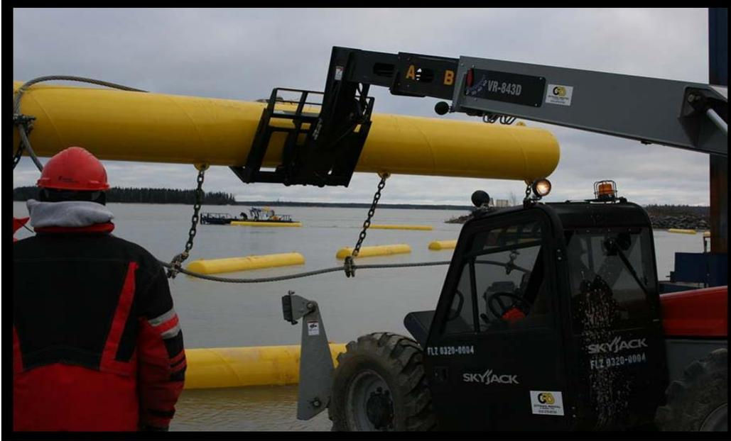
Figure 1. Estacade Géniglance câble, chaines et pontons en acier (pose avec machines)
