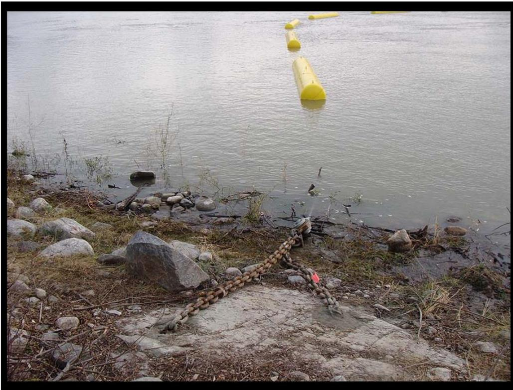
Figure 2. Ancrage typique d'estacade par Géniglance
